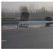
图11 安装翻新护栏板
