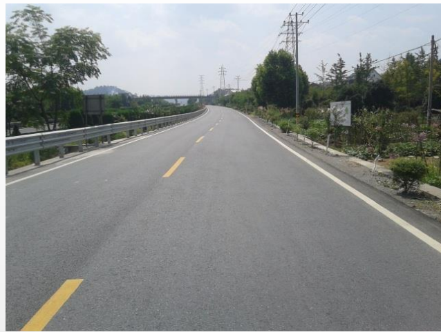
水泥二次冷再生路面（2年后）
